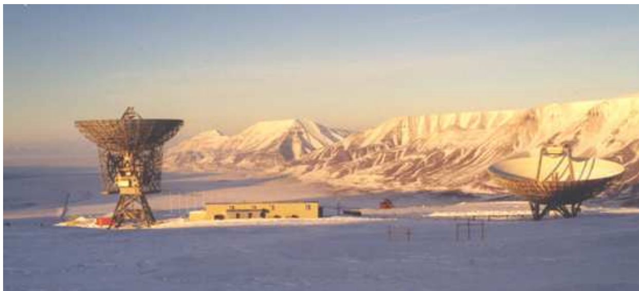
Fig.7. Les deux radars à diffusion incohérente de l'association scientifique EISCAT implantés sur l'île arctique du Spitzberg : l'antenne mobile de 32 m de diamètre à gauche, et l'antenne fixe de 42 m de diamètre à droite.
