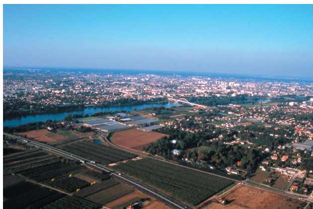
Vue aérienne d'Orléans (aval, sud-ouest).
