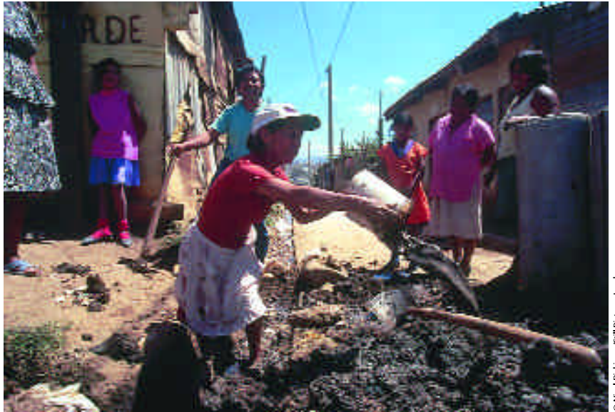
Un projet communautaire pour la construction d'égouts, à Ciudad de Guatemala.
