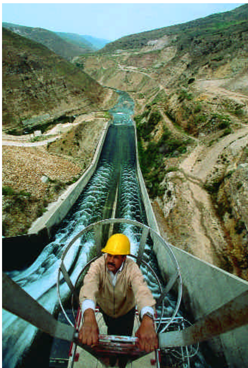
Le barrage du roi Talal fournit de l'eau aux fermes de la vallée du Jourdain.
