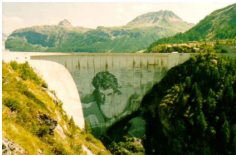
Barrage de Tignes, le plus haut de France (160 m il retient 230 millions de m 3 ) ; source : http://www.industrie.gouv.fr/energie/hydro/f1_hydro.htm
