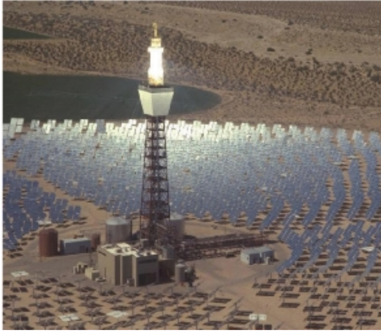
Tour solaire en Californie. Source : http://europa.eu.int/comm/energy/res/sectors/solar_thermal_power_en.htm
