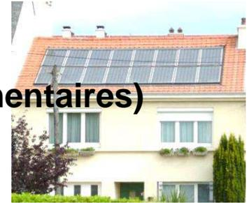
Avec une technologie au silicium polycristallin (rendement de 14%),
