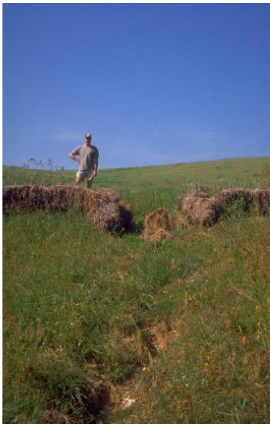
Photographie 18 : Diguette en paille en travers de talweg, vue de l'extrémité de l'ouvrage depuis l'amont (Bassin de l'Andelle, département de l'Eure); Y.Nedelec.
