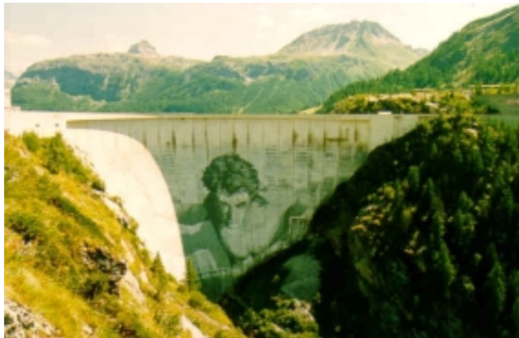
Barrage de Tignes, le plus haut de France (160 m il retient 230 millions de m 3 ) ; source : http://www.industrie.gouv.fr/energie/hydro/f1_hydro.htm
