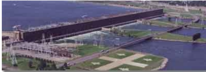
Centrale de Beauharnois au Québec : Puissance 1660MW ; hauteur de chute 24m ; source : http://www.hydroquebec.com/production/hydroelectrique/saint_laurent/beauharnois/index.html
